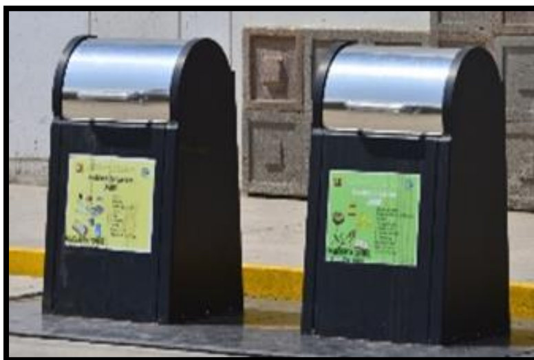
Figura 4. Instalación de contenedores soterrados
